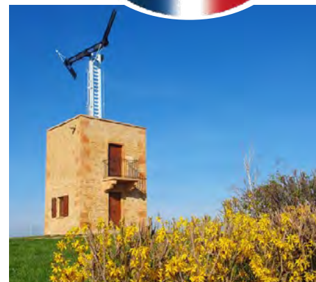
Télégraphe Chappe construit en 1821 sur la commune de Sonnay (Isère)
