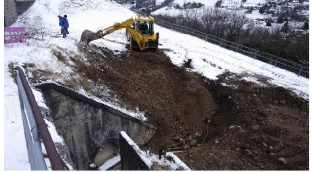
L'entrée de l'installation décantation-filtration que nous venons de découvrir se trouve maintenant au fond d'un profond entonnoir. Il faut l'élargir pour sécuriser les bords avant de pénétrer à l'intérieur.
